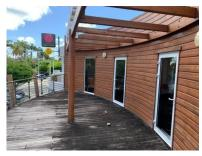
La structure du bâtiment est en béton armé et en structure bois, le tout est recouvert par une toiture terrasse non accessible lors de la visite. Les façades sont en bardage à lames en bois et en béton, recouvertes par de la peinture. Les sols au RDC sont en carrelage de même que le bureau à l'étage. On retrouve un sol en bois du type parquet flottant au niveau de la salle de réunion du R+1 et un plancher en bois du type deck pour la terrasse.
