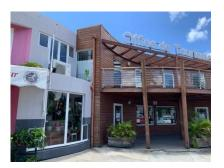
Le bâtiment est de conception très contemporaine avec un mélange de structure béton armé, et de structure bois. Le bâtiment est composée d'un noyau central et de chaque côté deux appendices en béton identique. Le fleuriste se situe d'ailleurs dans l'appendice côté Sud, il faut noter que les deux activités sont séparées par un mur en béton armé.
